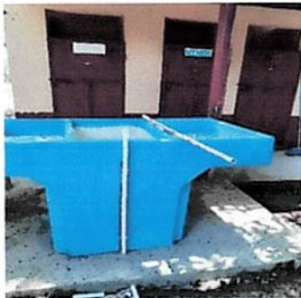
Foto 5: Sustitución de pila
