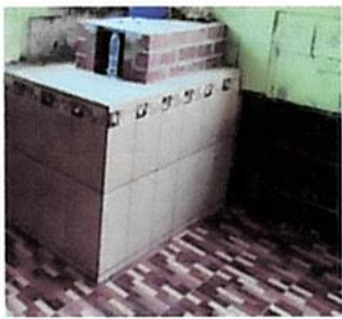
Foto 3: :Instalación de estufa rural, restauración de cableado eléctrico con sus Conductos, instalación de tomacorriente y sus lampara led ahorrador.
